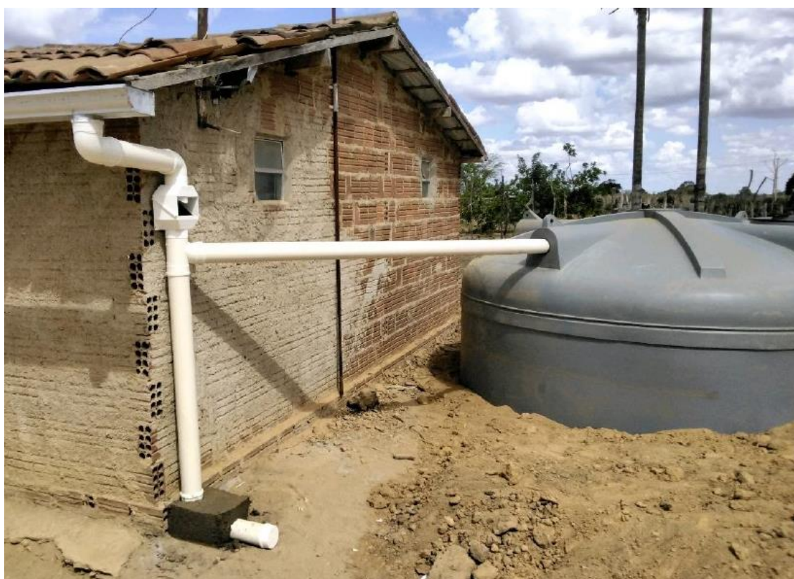
Figura 8: Visão geral da cisterna instalada.
